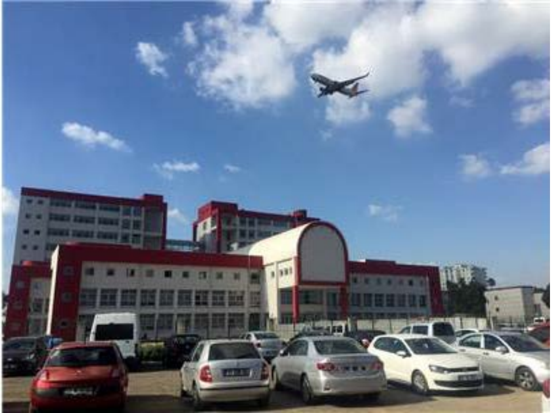
Şekil 2.8: Adana Emniyet Müdürlüğü Hizmet Binası 3.
