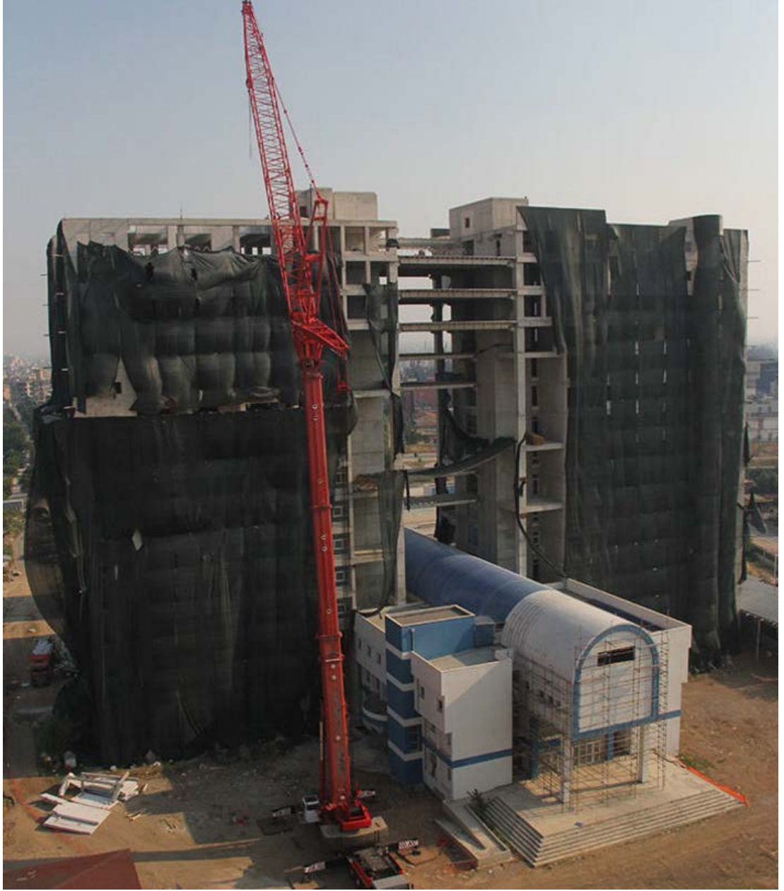
Şekil 2.9: Adana Emniyet Müdürlüğü Hizmet Binası 4.
