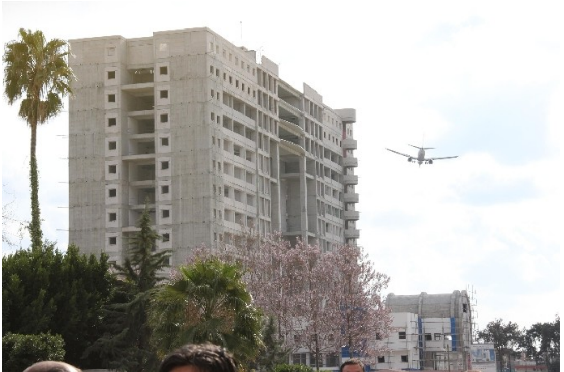
Şekil 2.6: Adana Emniyet Müdürlüğü Hizmet Binası 1.
