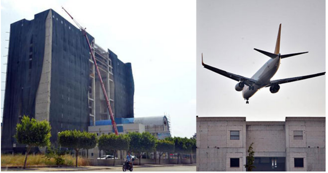
Şekil 2.7: Adana Emniyet Müdürlüğü Hizmet Binası 2.
