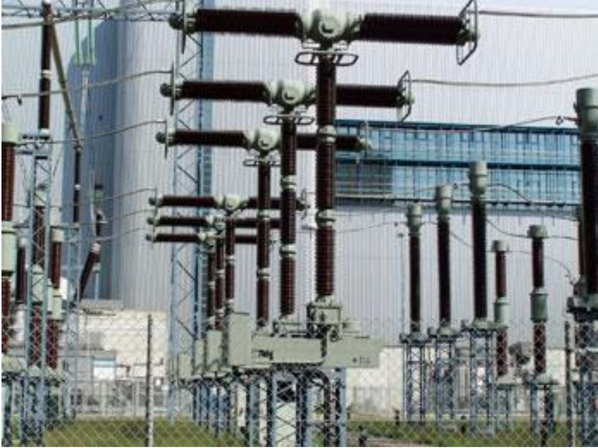
Yalıtılmış gövdeli (live tank)
