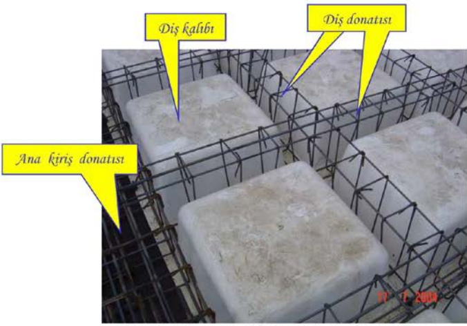
Dış donatıları yerleştirilmiş, plak donatısı henüz yok.
