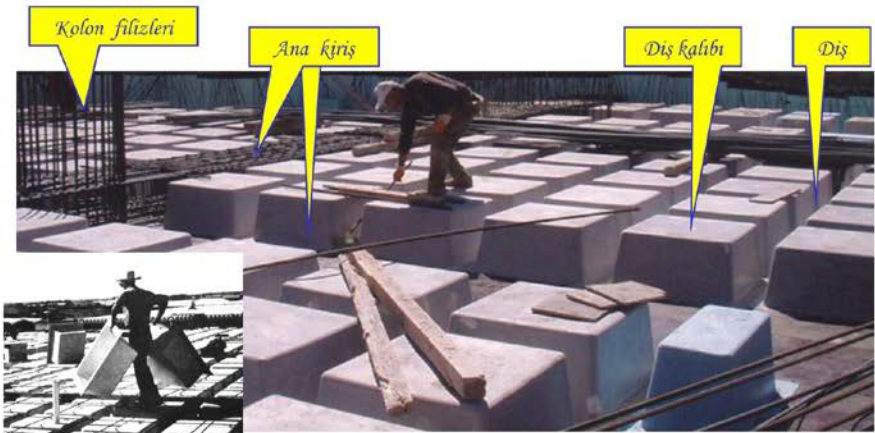
Dış kalıpları dizilmiş, ana kiriş donatıları yerleştiriliyor
