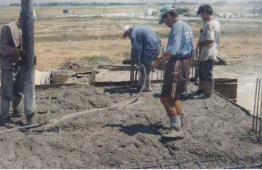
Kat betonu dökülüyor ve sıkıştırılıyor
