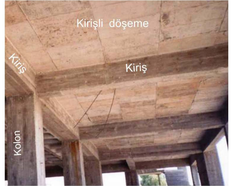
Kalıp söküldükten sonra alttan görünüş
