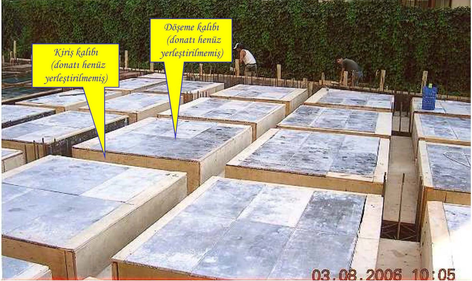
Kiriş-döşeme kalıbı hazırlanıyor
