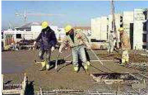
Dalgıç vibratör uygulaması
