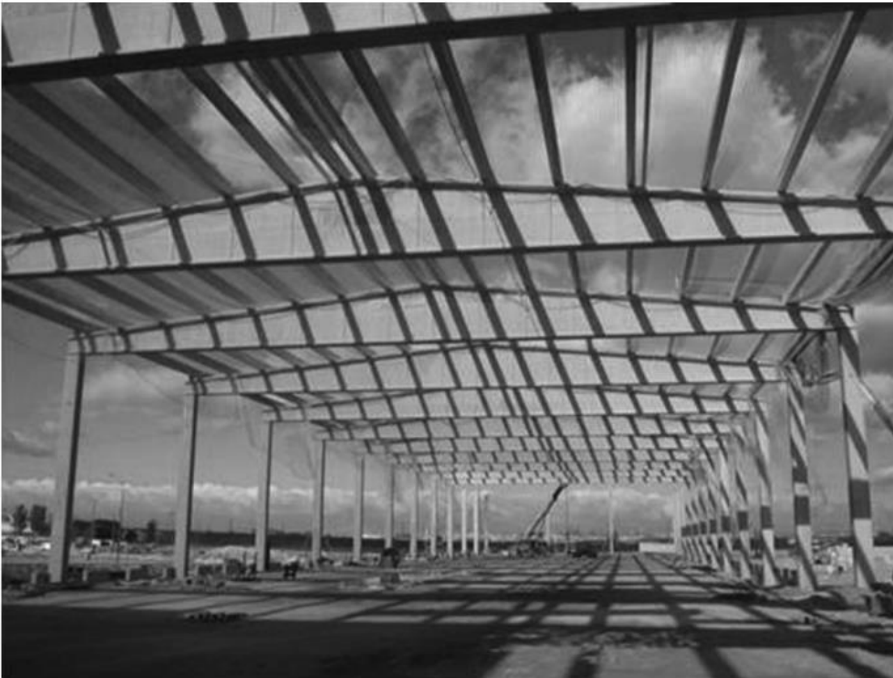
Figure 3.9 Precast portal frame. (Courtesy David Fernandez-Ordoñez, Escuela Técnica Superior de Ingeniería Civil, Madrid, Spain.)
