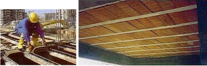
Prefabrik dişli kil asmolen döşeme
