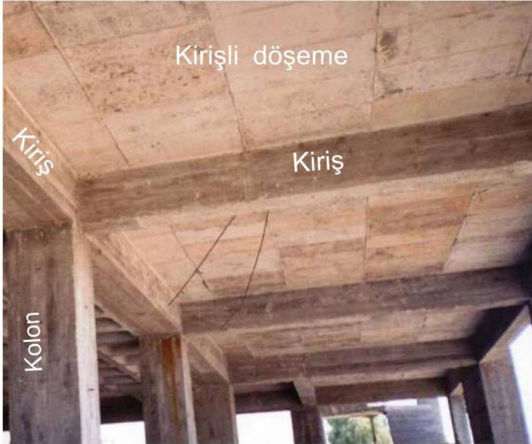
Kalıp söküldükten sonra alttan görünüş
