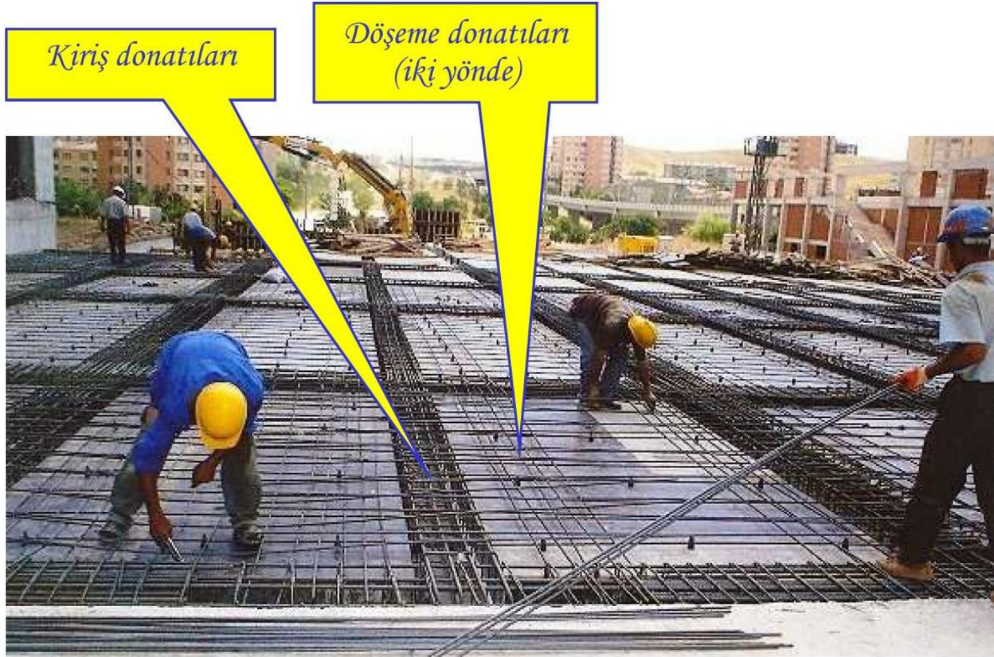
Kiriş donatıları yerleştirilmiş, döşeme donatıları yerleştiriliyor
