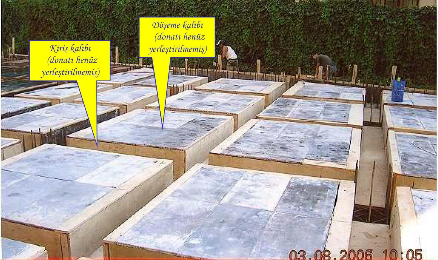
Kiriş-döşeme kalıbı hazırlanıyor
