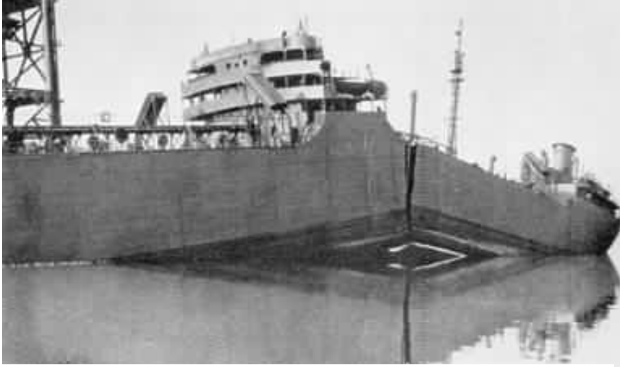
SS Schenectady'nin gevrek kırılması, Ocak 1943
