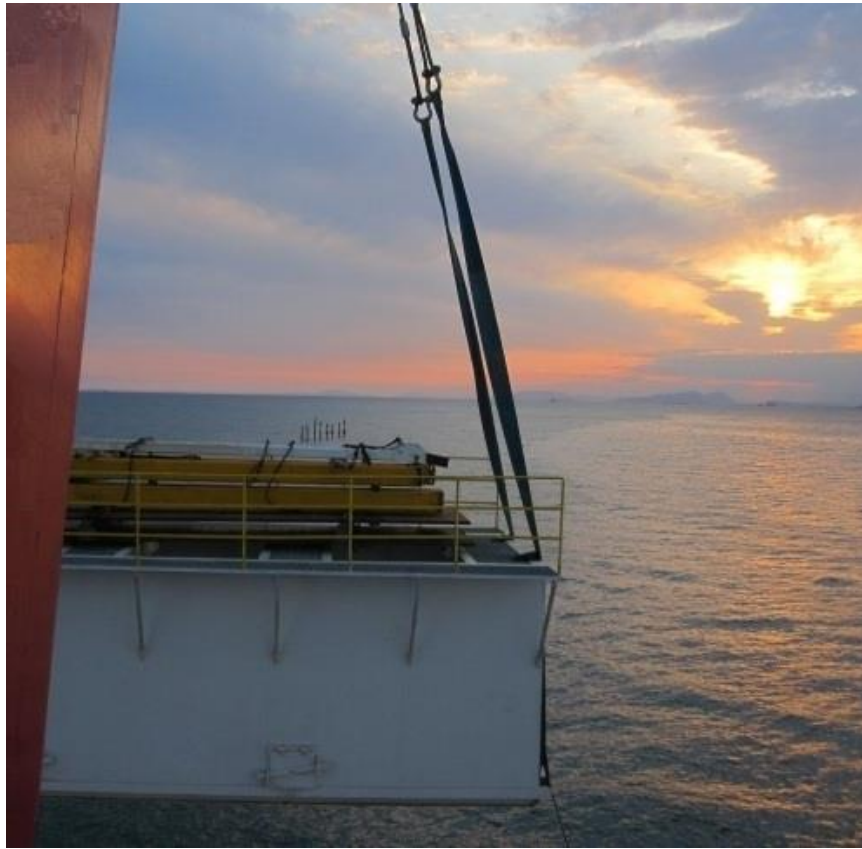
Şekil 3.7 : Kren_1'de test yükünün kaldırılması.
