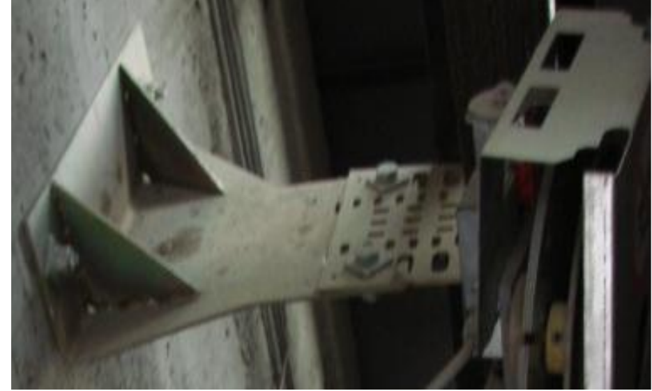
Şekil 1. Konsol eğilmesi, hasara uğraması (İmrak, 2012)*.
