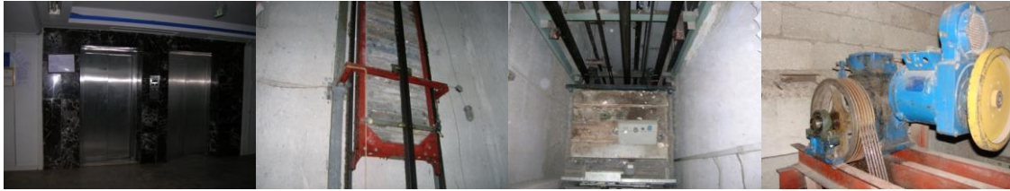
Şekil 5. Hastane asansörlerinin deprem sonrası durumu.
