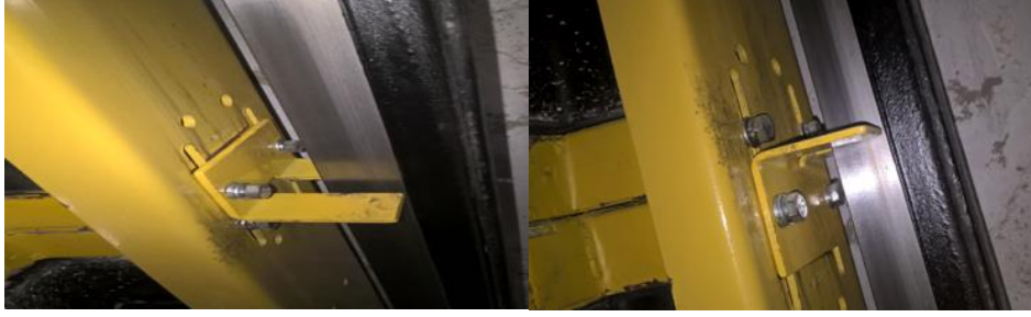
Şekil 10. Karşı ağırlık çıkmasına engelleyici
